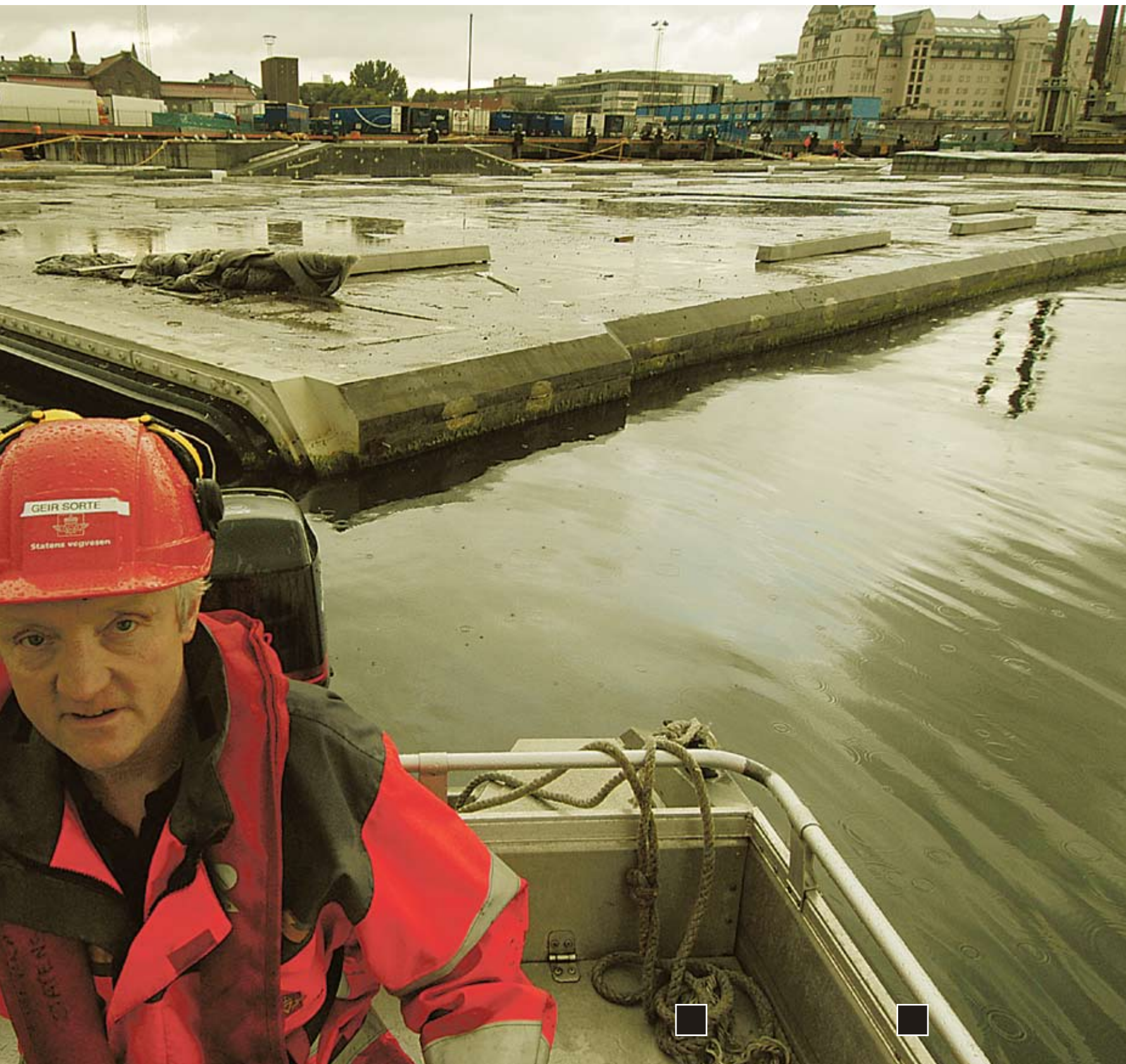
Senketunnel: Byggeleder Geir Sorte foran tunnel-element 2 til Bjørvikaforbindingen. (Foto: Håkon Aurlien)
