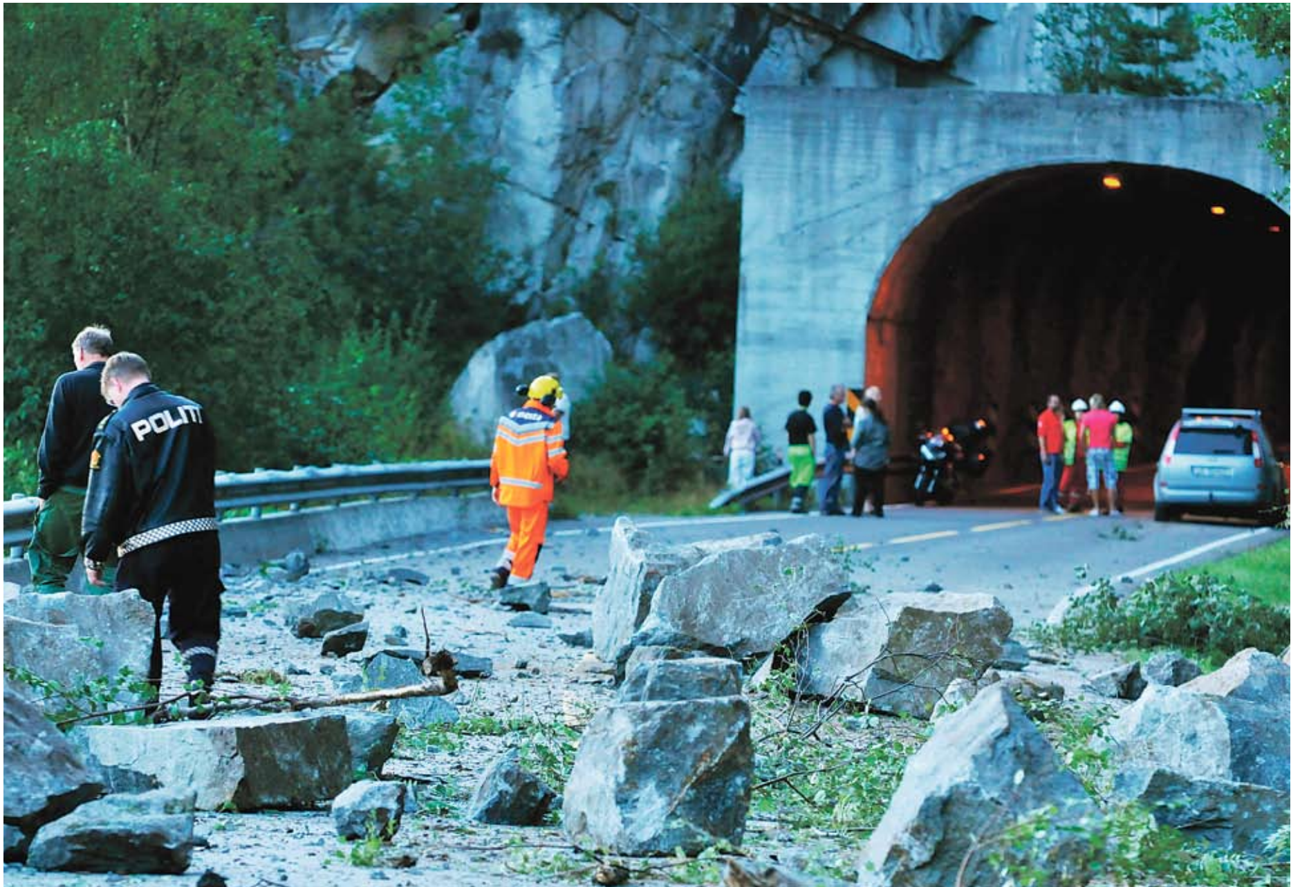
Store steiner: En person ble alvorlig skadet da store steiner raste ned i vegbanen ved Oppdølstranda i Møre og Romsdal søndag 24. august. (Foto: Kjell Ove Holsbøvåg, Tidens Krav)
