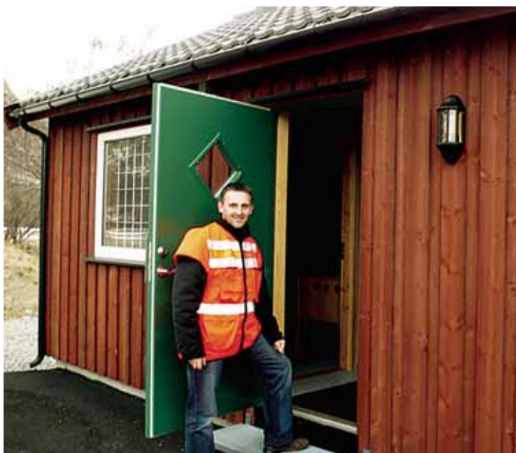
På ferdigbefaring: TK-leder Jan-Erik Myhr i Nordmøre og Romsdal distrikt er tilfreds med den nye kontrollstasjonen. (Foto: Reidun Øverland)
