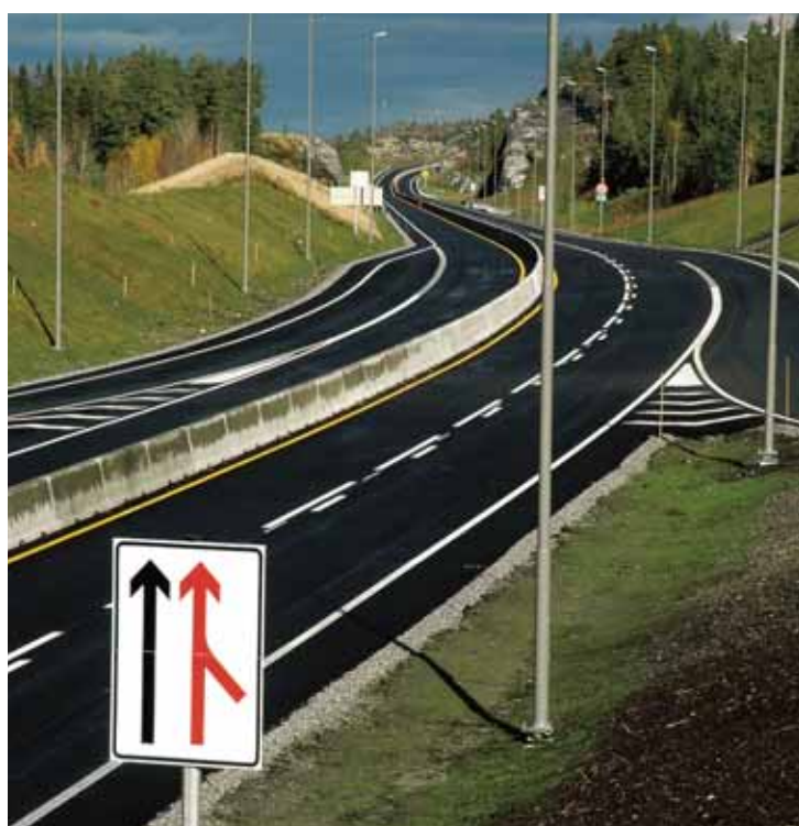
Ulykkesfri: E18 Brokelandsheia-Vinterkjær i Aust-Agder opna 1. nov. 2004 med midtrekkverk heile vegen. Fasit: Ingen dødsulykker eller alvorlege ulykker på tre år. (Foto: Kjell Wold)
