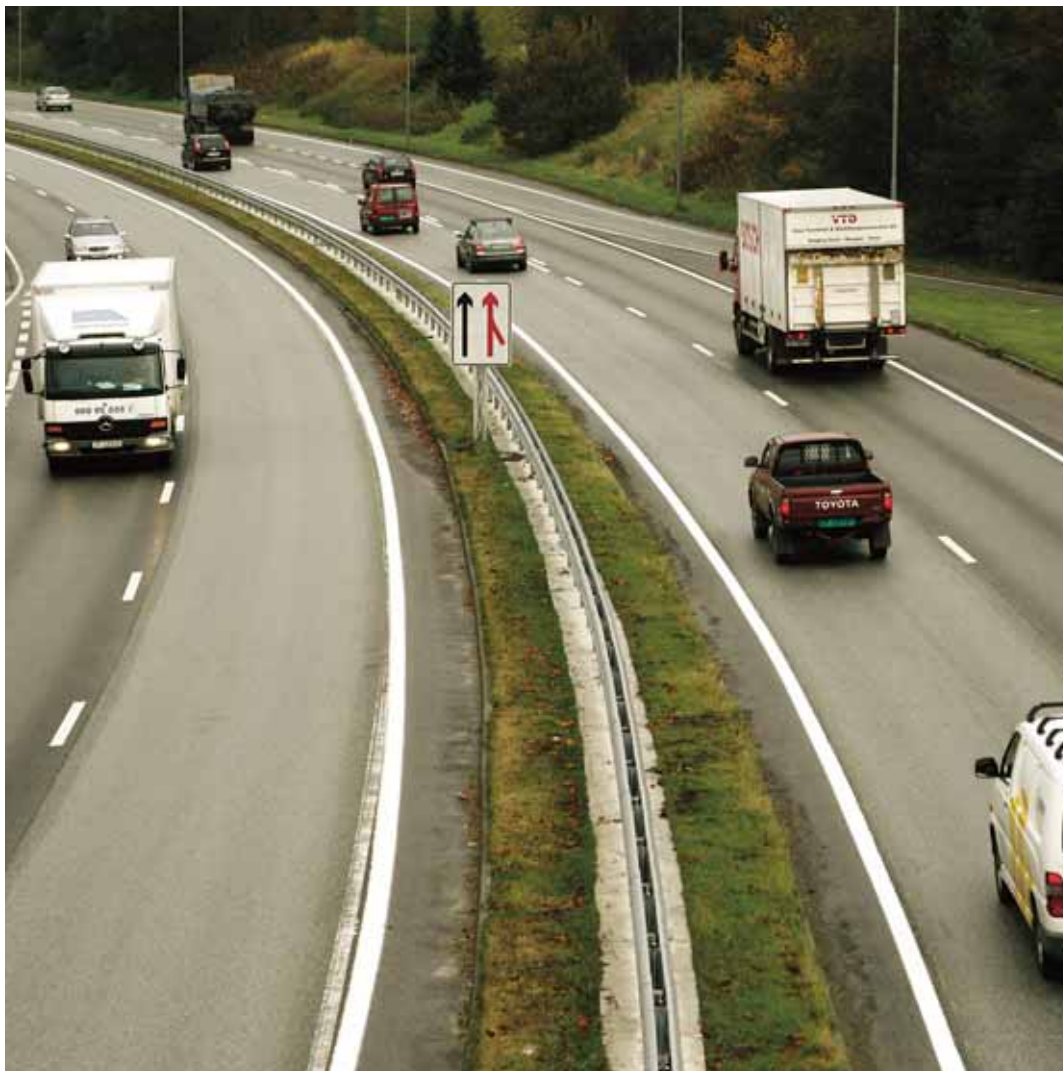
Løsningen: Med midtdeler på vegnettet kan mange av de mest alvorlige trafikkulykkene unngås, tror biskop Tor B. Jørgensen. (Arkivfoto: Geir Brekke)
