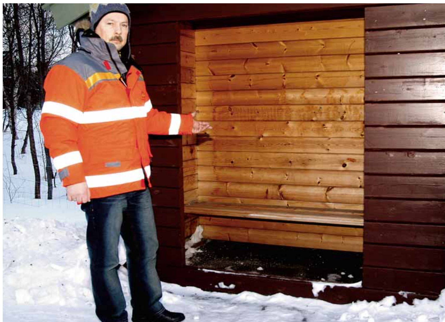
Godkjent. Byggeleder Torkjell Johnsen inspiserer leskuret på bussholdeplassen ved Lakselv. Entreprenøren har forpliktet seg til å rydde leskuret innen kl 0700 om morgenen. Her ser alt ut til å være i orden. (Foto: Giselle Jensen)
