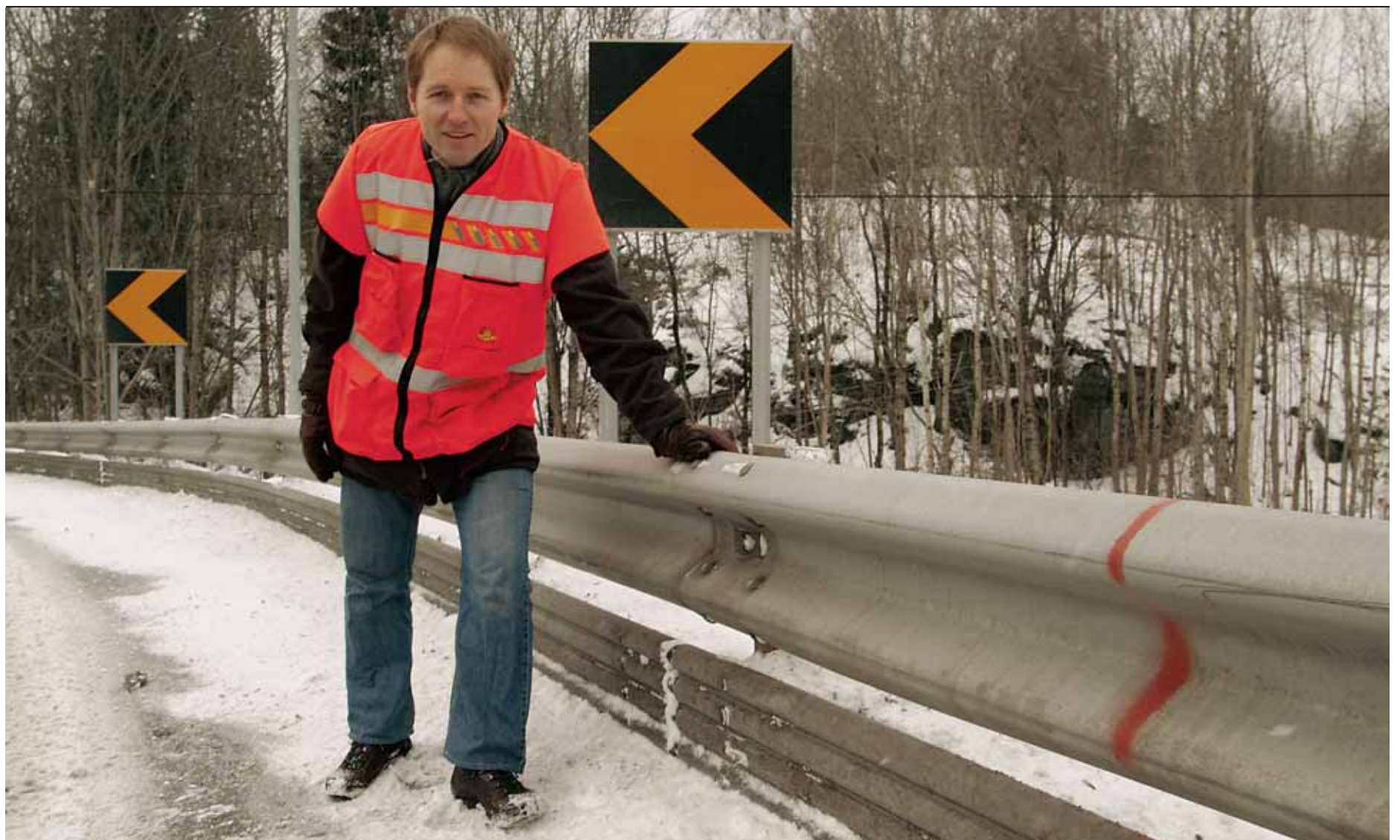
MC-rekkverk: Bjørn Richard Kirste i Statens vegvesen med det nye MC-rekkverket som nå settes opp på en rekke streder langs rv. 32 mellom Siljan og Skien. (Foto: Kjell Wold)
