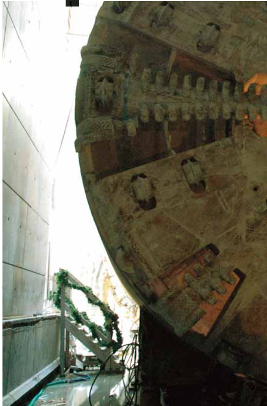
TBM: Fullprofil boremaskin som brukes på City tunnelen i Malmø. (Foto: Alf Trygve Kve
