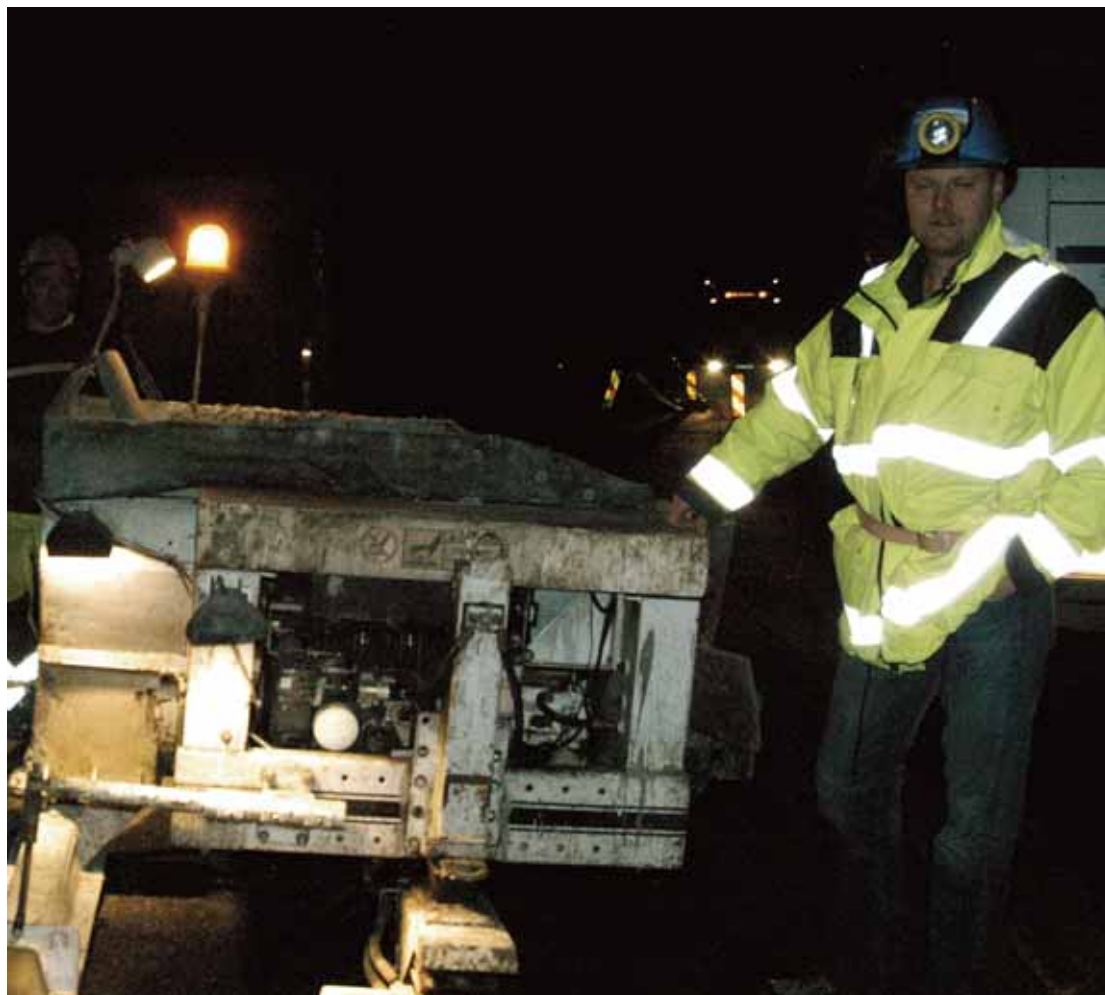
Omfattende: Anleggsleder Per Åge Havnegjerde er en av 35 mann i sving når i Tunnelteknikk AS foretar en tung og kostbar rehabilitering av Hvalertunnelen. (Foto: Håkon Aurlien)
