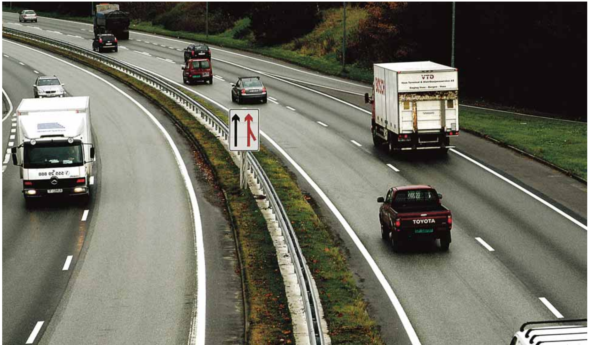
Mer midtrekkverk: Veger med mer enn 8 000 i døgtrafikk skal ha midtrekkverk, går det fram av forslaget som Statens vegvesen nå arbeider med for NTP 2010-19. (Foto: Geir Brekke)
