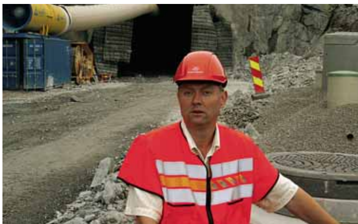
Ny Kragerøveg: Prosjektleder Jørn Rinde i Statens vegvesen tror prosjektet blir ferdig til åpning sent neste høst. (Foto: Kjell Wold)
