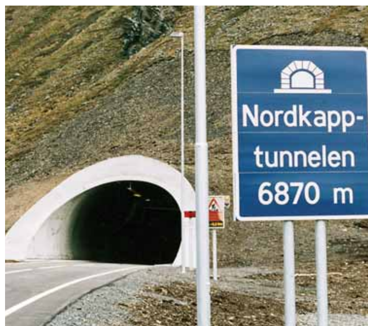
Utvikler tunneler: Statens vegvesen starter et nytt forskningsprosjekt om tunnelbygging på nyåret. (Arkivfoto: Henriette Erken Busterud)
