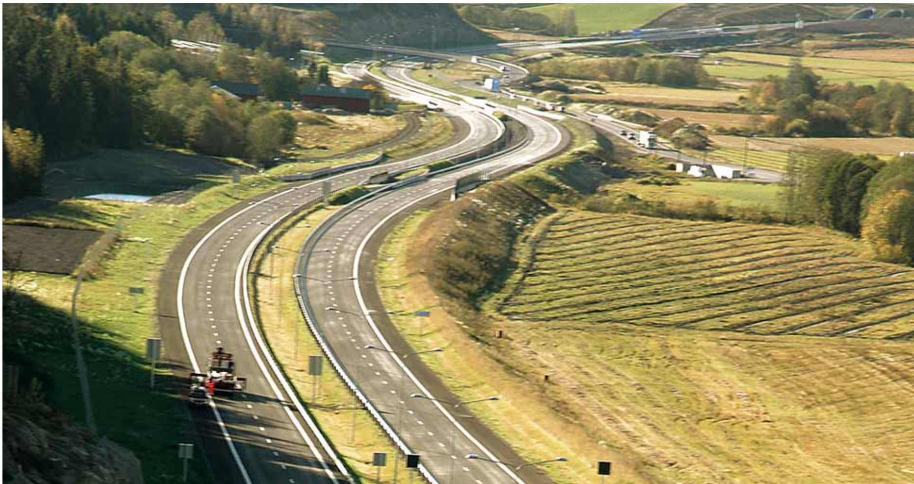
Ny motorveg: 12 km ny fire felts motorveg mellom Horten og Tønsberg. Her sett fra Hemtunnelen i Re og sørover mot Tveiten og Ekeberg-Gulli i Tønsberg. (Foto: Kjell Wold)
