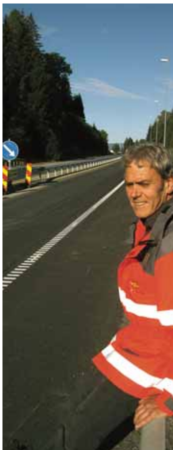
4,7 km midtrekkverk: Pål Rødby i Statens vegvesen ved startpunktet for det nye midtrekkverket på E134 ved Gulsbogen. (Foto: Kjell Wold)
