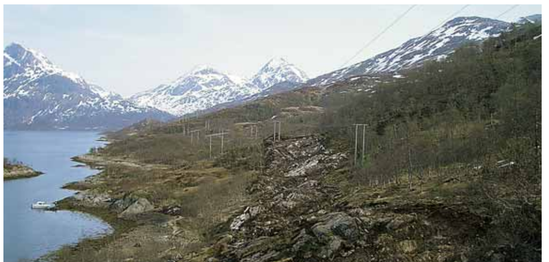
Øksfjorden. Tynne vekstmasser på fjellet er tatt til side før traseen mot tunnelpåhugget til Sørðalstunnelen sprenges ut. (Foto: Elisabet Kongsbakk)
