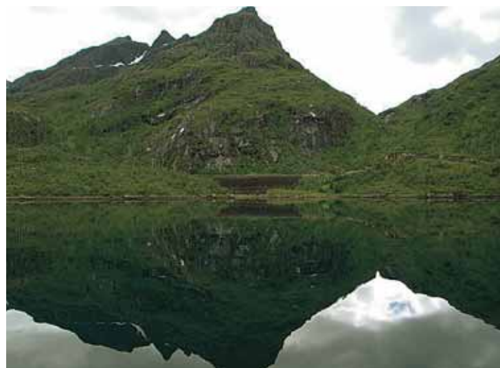
Svartskarvika. Her er bygget en 37,5 grader bratt skråning kledd med vekstmasser lagt rett på steinfylling. (Foto Jan Fredrik Eliassen)
