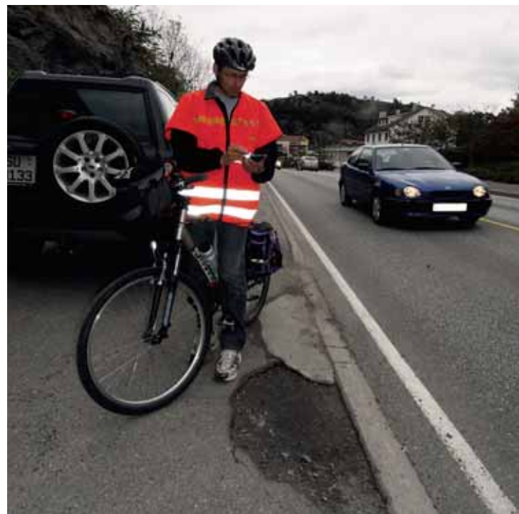
Veltefelle: Svein Viken registrerer eit farleg hol i sykkelvegen som må fyllast att. (Foto: Geir Brekke)
