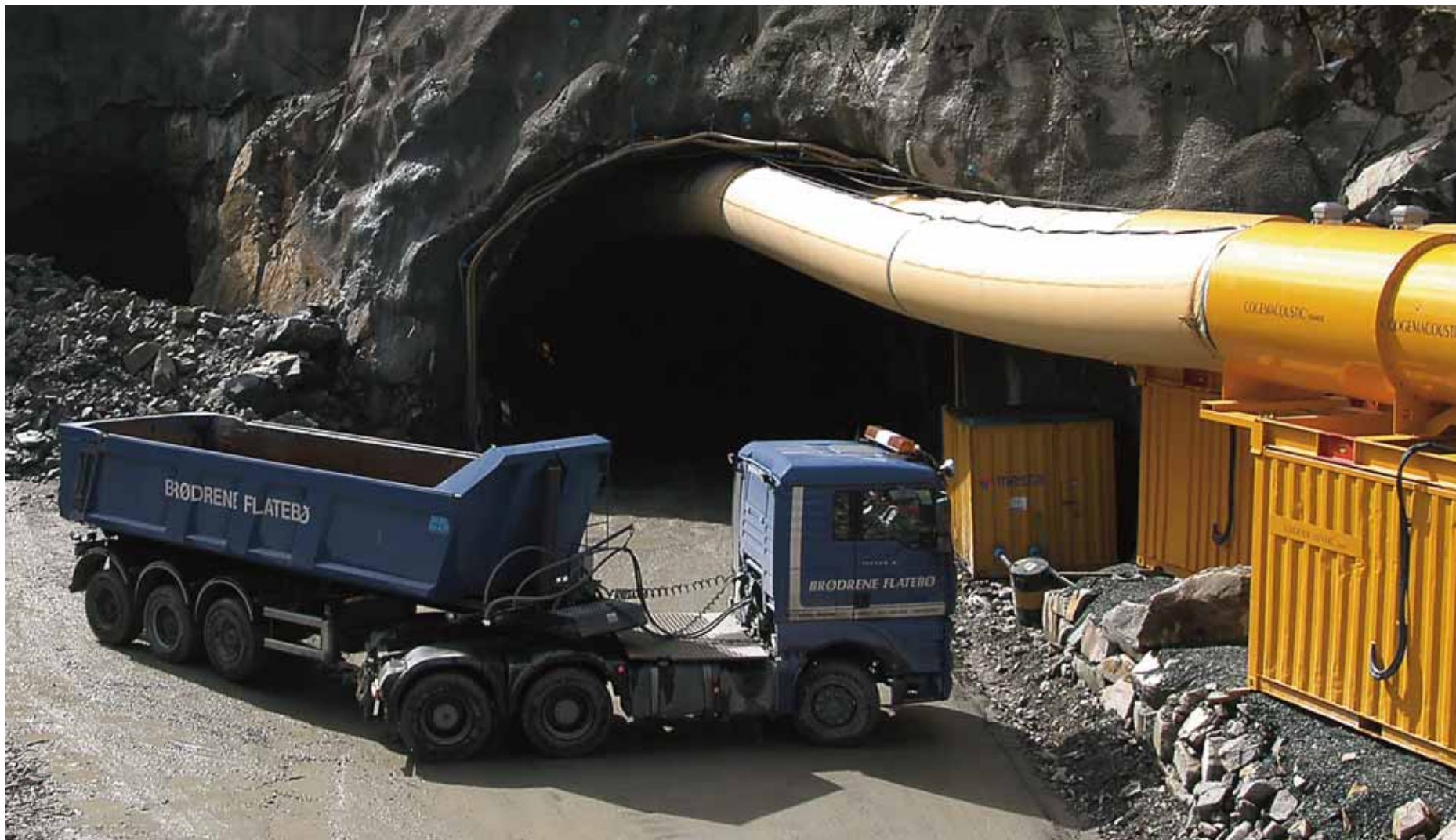
Utvidet profil: Toløpstunnelen på Ringveg Vest i Bergen er ett av prosjektene der man nå vurderer å utvide profilen på resten av sprengingsarbeidet. (Foto: Geir Brekke)
