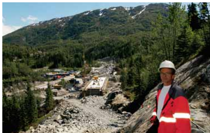
God framdrift: Byggjear Morten Thorbjørnsen i Statens vegvesen er godt nøgd med framdrifta på dei tre bruene på nye E134 ved Vinterun. (Foto: Geir Brekke)
