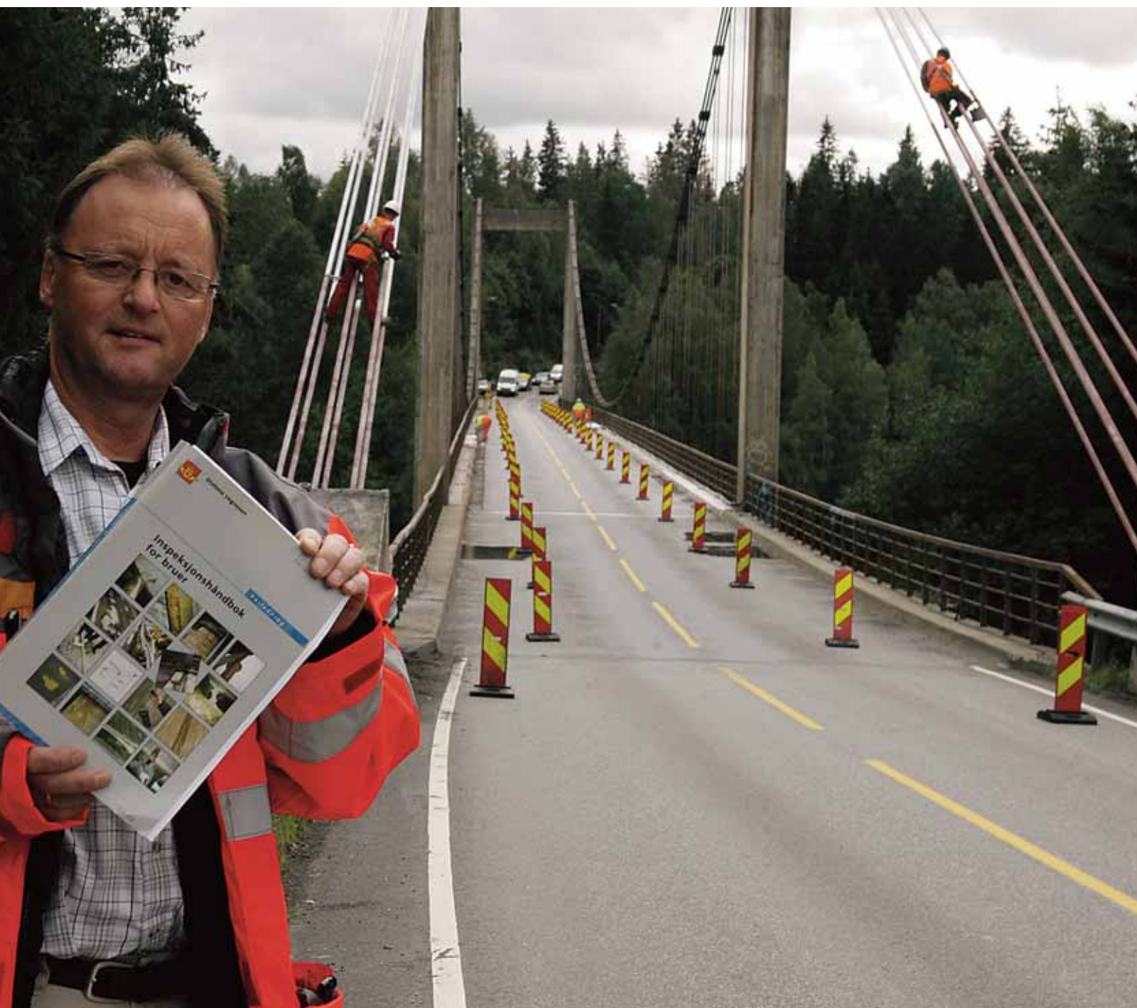
På systemet som sikrer oversikt over tilstanden på 16700 riks- og fylkesvegbruer i Norge, her Vammabrua på rv. 115. (Foto: Håkon Aurlien)
