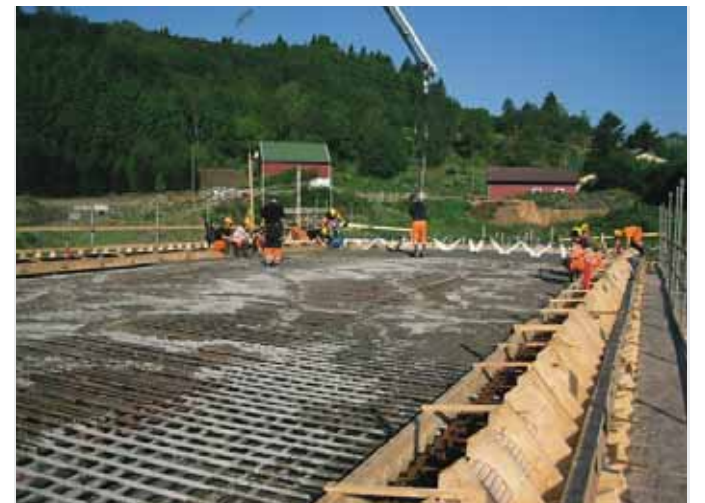
Brustøp: Mannskapene venter på ny betongforsyning. (Foto: Magnar Teigen)
