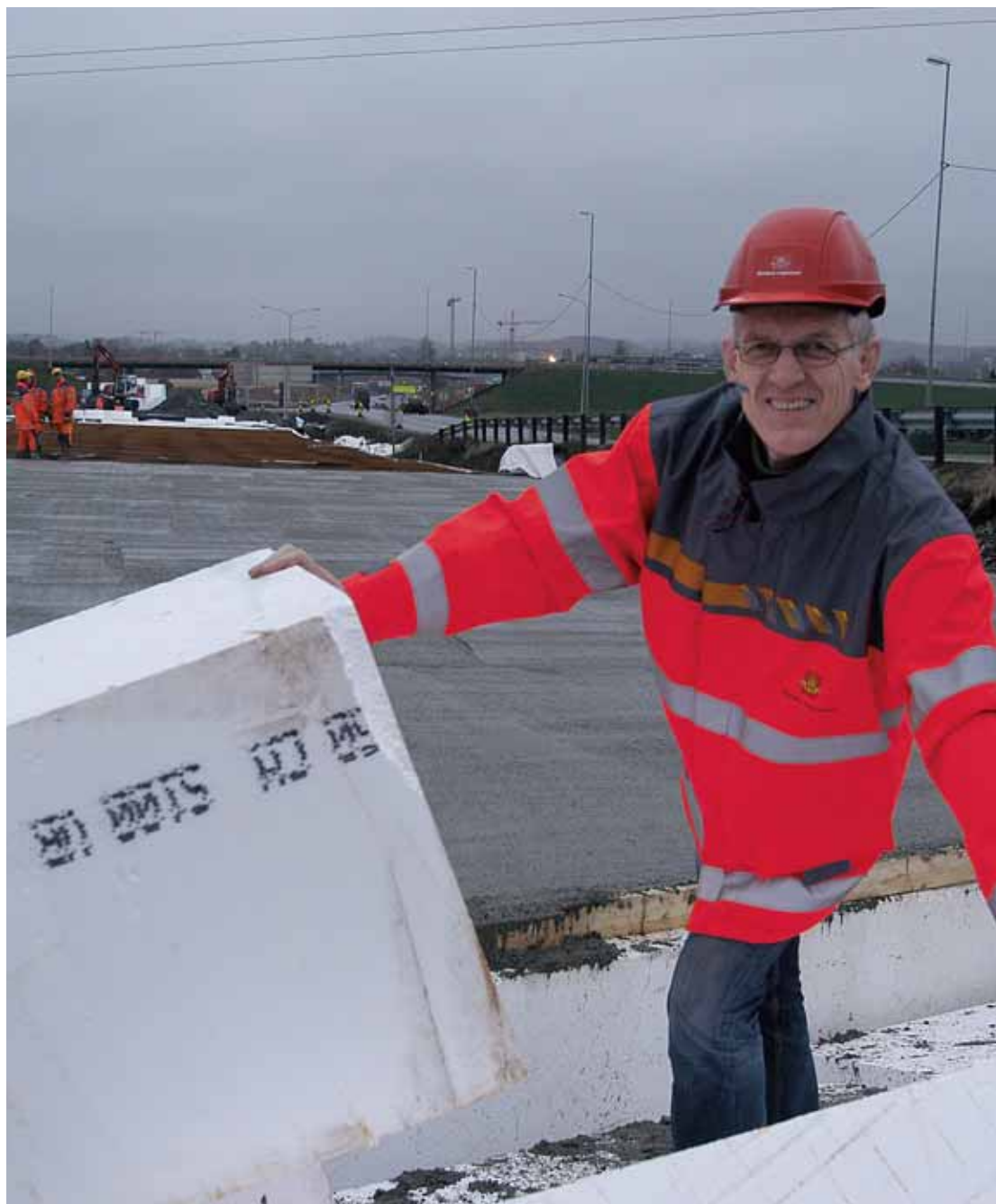
EPS og leca: - Dette sikrer stabiliteten og reduserer faren for setninger, forteller Magne A. Lurfaldet. (Foto: Håkon Aurlien)
