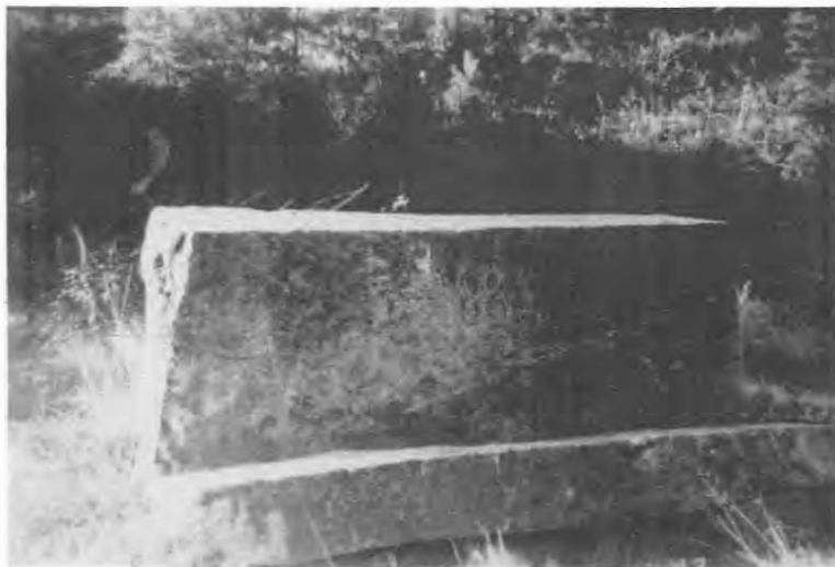
I 1887 satte vegvesenet opp denne Ja-benken på riksveg 12 ved Vassend bru i Byglandsfjord.
