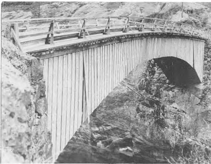
Gamle Flåren bru i Valle har en spennvidde på 31,0 m, kjørebane 3,80 m, med brudekke av tre. Brua er bygget i 1867.
