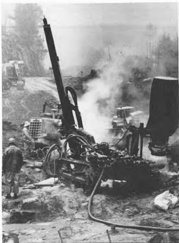
Med en borrhøg som denne oppnår man mellom 90 – 120 bormeter pr. dag. (Foto: Høg)
