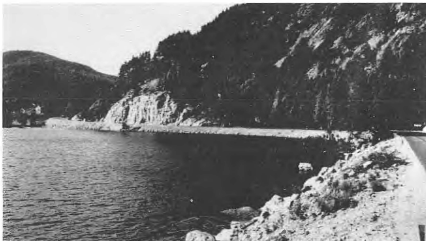
Parti av rv. 12 ved Tjuvneset i Bygland, anlegg som har fått fast dekke.
