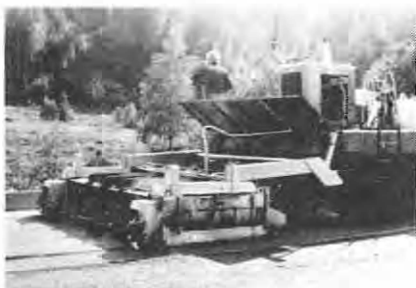
Heateren montert bak utleggeren,
