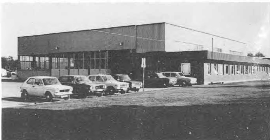
Hovedbygget sett fra vest.
