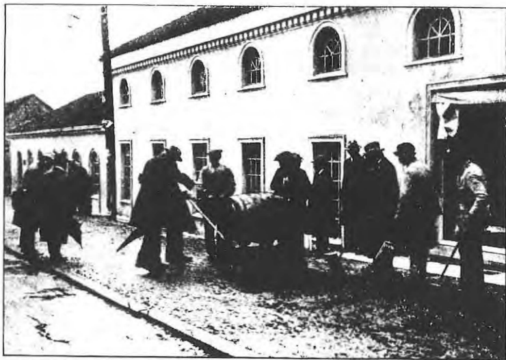
Første utlegning av Koldmex med vogner på hovedveien Stavanger-Sandnæs i overvær av diverse veiautoriteter fra Vestlandet.
