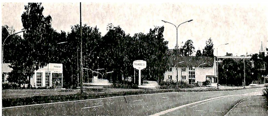
Stort skilt — intenst lys — nær vegkant. Stasjonen stengt — venstresving forbudt.
