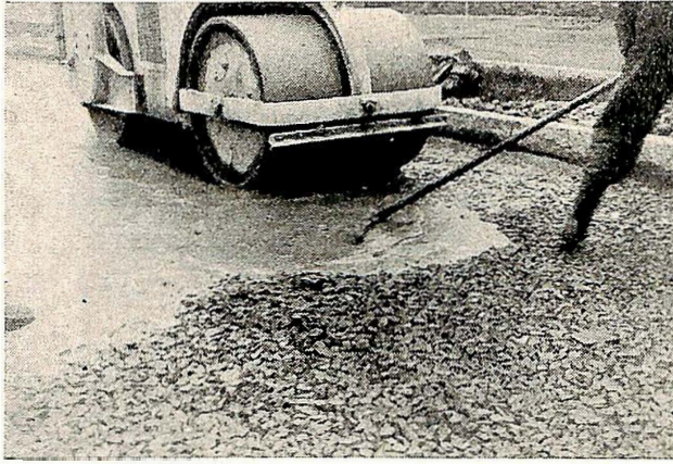
Fig. 7. Mørtelen vibreres lett ned i pukklaget som ettervalses.
