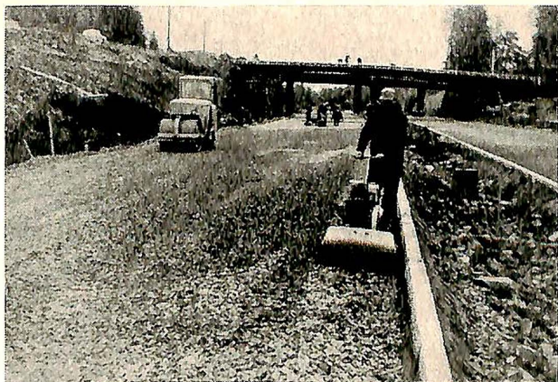
Fig. 5. Forkiling av pukke med vibrovalse og vibroplate langs kantsteinene.
