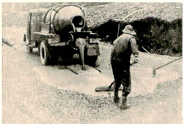
Fig. 6. Tømming av trommelbil. Legg merke til trebrettet som forhindrer at pukklaget rives opp.
