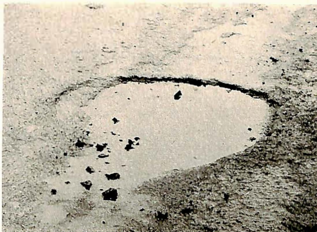
Fig. 1. Vanntilsig før lapping.
