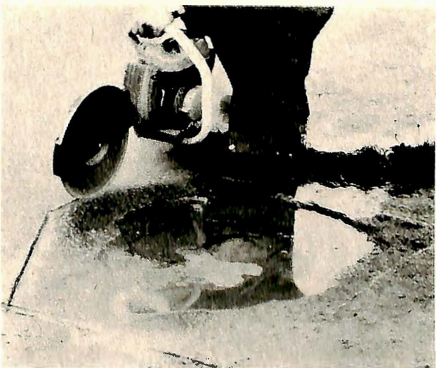
Fig. 2. Avmerking med kritt og skjæring med motorsag.
