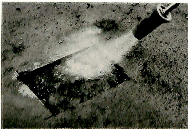
Fig. 4. Oppvarming og delvis tørring med propangassflammekaster.
