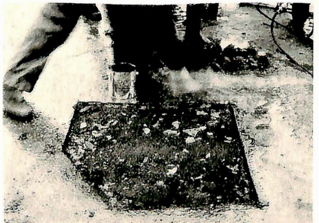
Fig. 6. Avjevning og stamping i bunn av hull med lappemasse.
