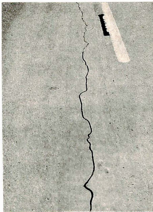
Fig. 10. Fullført reparasjon av langsgående revne på Motorveg M 1. Alder 2 år.
