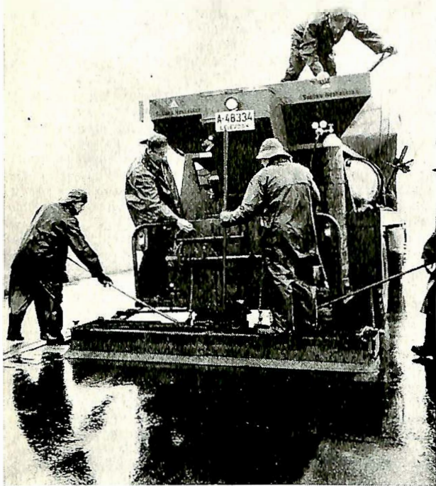
Fig. 1. «Slurry Seal»-maskinen demonstreres på Torp flyplass.
