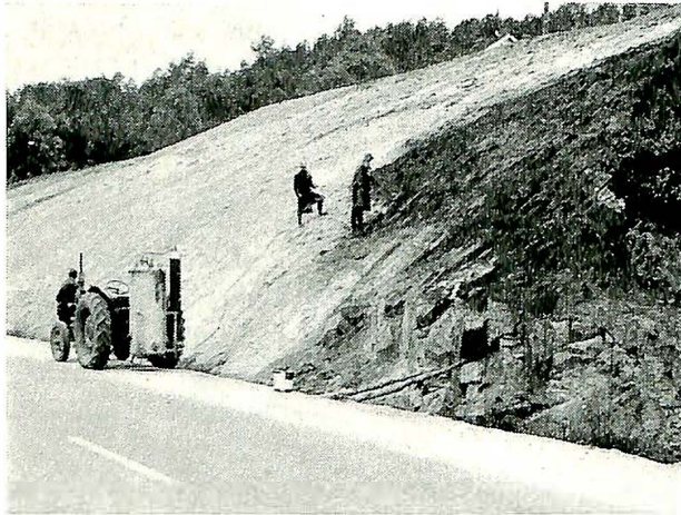
Fig. 1. Påsprøyting av asfaltemulsjonen ved Fiane.
