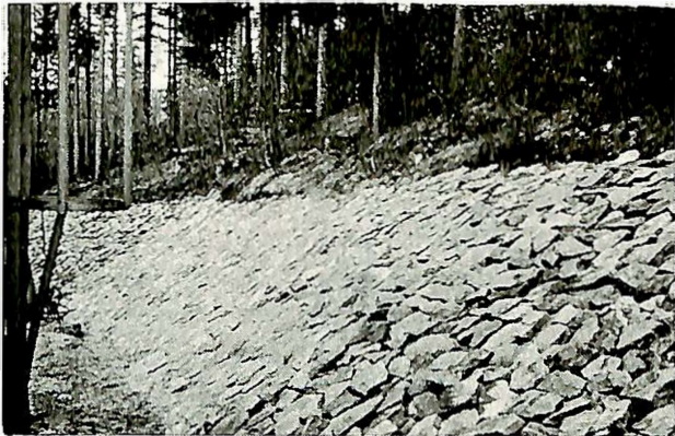
Fig. 13. Stein og grusdekke ved bratt skråning i siltige materialer.
