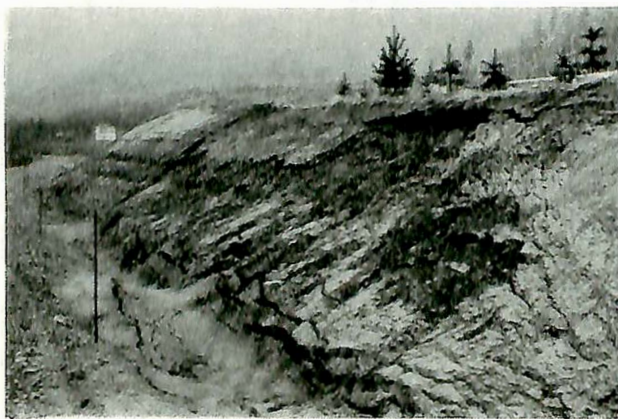
Fig. 9. Konsentrert erosjon fra overflatevann.
