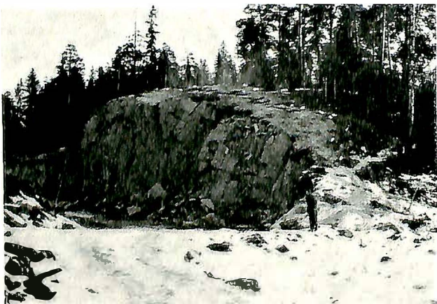
Fig. 4. Siste salve før sprengning.
