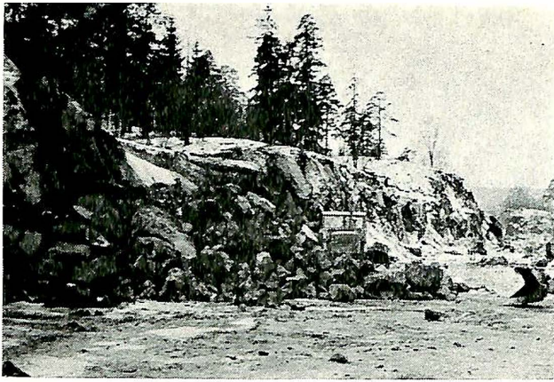
Fig. 3. Grovblokket, nedsprengt overheng.
