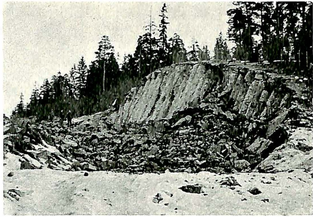
Fig. 5. Siste salve etter sprengning.
