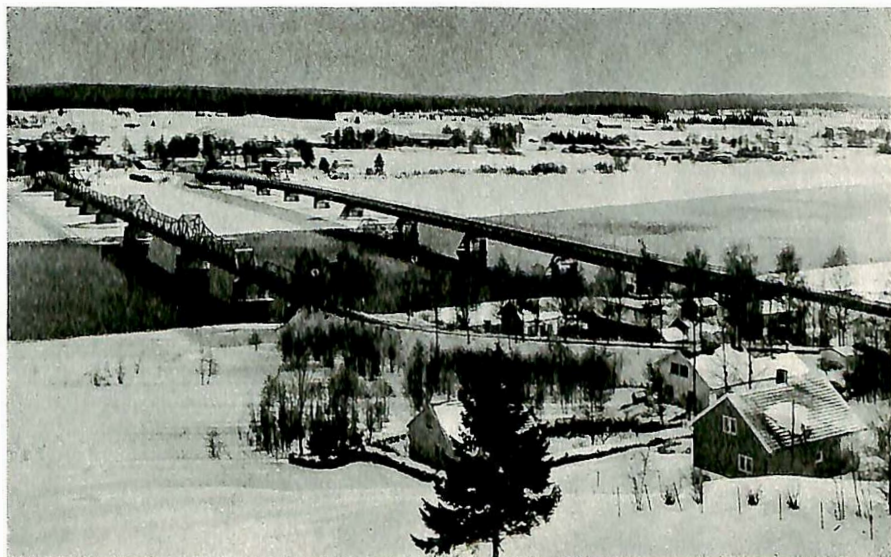
Fig. 1. Den gamle fagverksbru og den nye spennbetongbru.
