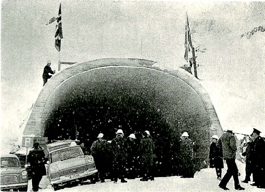
Fig. 2. Flagheising på tunnelportalen i Gorsbotn.
