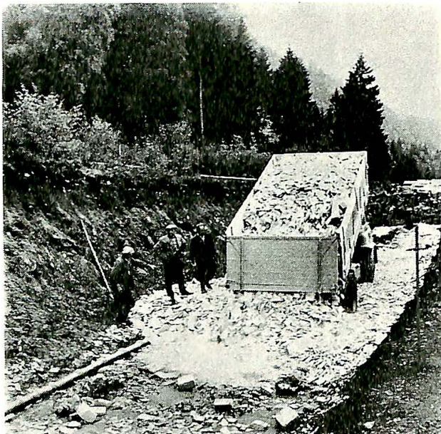
Fig. 8. Fra arbeidet ved Sjøskogen.
