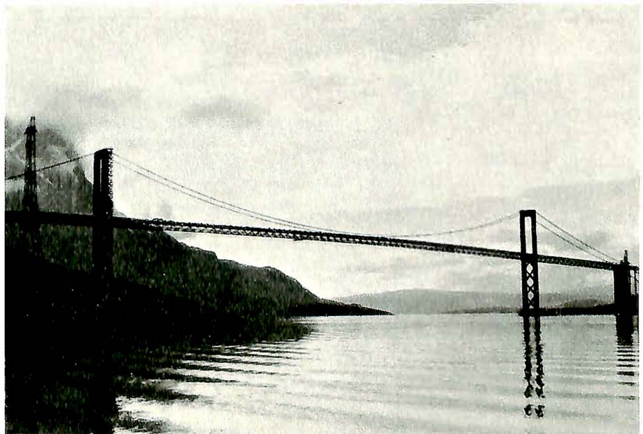
Fig. 12. Rombaksbrua ved Narvik. Åpnet september 1964.
