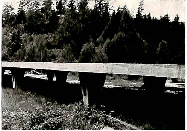
Fig. 5. Brua etter at forskaling og stillas er fjernet. Stillaset var opplagt på bjelker gjennom spaltene i pelhodene.
