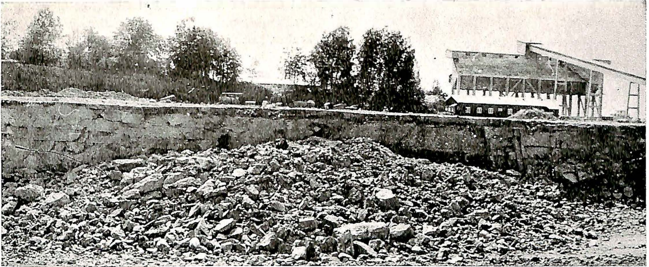
Fig. 1. Salve på 8000 m 3 skutt med ammoniumnitrat/olje. 16 stk. 6¼" borhull, 18 m dype og med hullavstand og forsetning henholdsvis 6 m og 5 m. (Christiania Portland Cementfabriks kalksteinbrudd på Langøya.)
