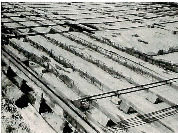
Fig. 2. Kablane er faststøpte ved midten av plata.
