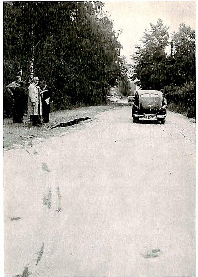
Fig. 5. Nedslitte, snittede dekk. Tørr asfalt, hastighet 60 km/h.
