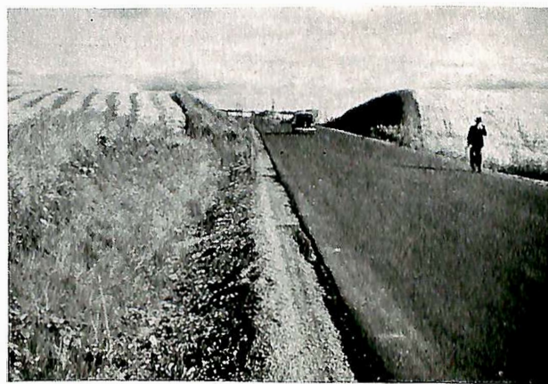
Fig. 4. Veg som ble lagt om for legging av fast dekke. Gjennomgående åpne grøfter er anordnet.
