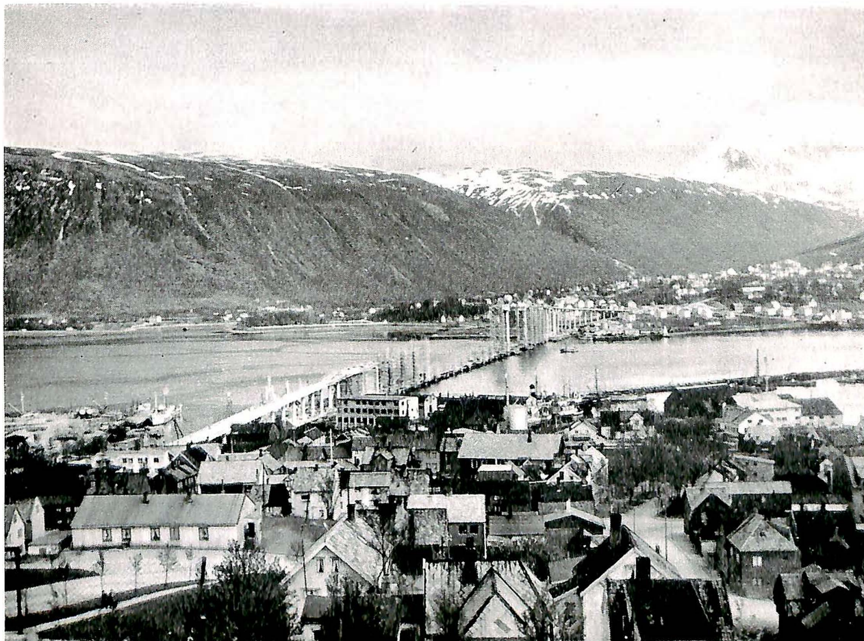
Grunnsteinen til Tromsøbrua ble nedlagt den 13. mars 1958. Bruas totale lengde blir 1036 m. Skipsløpets frie høyde blir 38 m med spennvidde 80 m. Brua får kjørebredde = 6.75 m og 2 fortau á 0.75 m. Den skal være ferdig 1. juli 1960. Bildet viser situasjonen 1. juni 1959.
