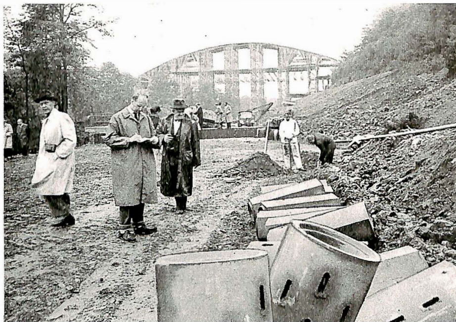
Fig. 9. Cementrøyr med sidehol for vassinnlaup. Vi ser Blombach-brua i bakgrunnen.
