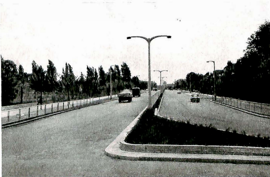
Fig. 7. Dette er ein lastebilveg (tungtrafikk-veg) som fører vestover frå London. Her har dei ei køyrebane for kvar køyreretning og med ei smal skiljeremse imellom. Men dei har tett gjerde både på skiljeremsa og stykkevis på ytre sida av kvar køyrebane. Der er breid skiljeremse mellom køyrebanelar og gongvegar og. Det er fotografert frå eit vegdele
