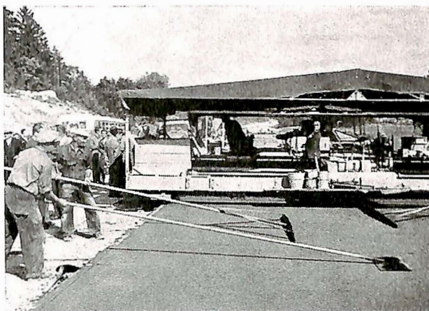
Fig. 8. Fra byggingen av Norrtäljevägen i Sverige. Ved omhyggelig arbeid har man oppnådd et dekke med mindre ujevnheter enn ved noe annet veidekke tidligere.
