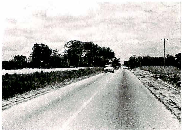
Fig. 12. Den første virkelige soil-cementvei nær Johnsonville i South Carolina er fremdeles i god stand etter 20 års bruk.
