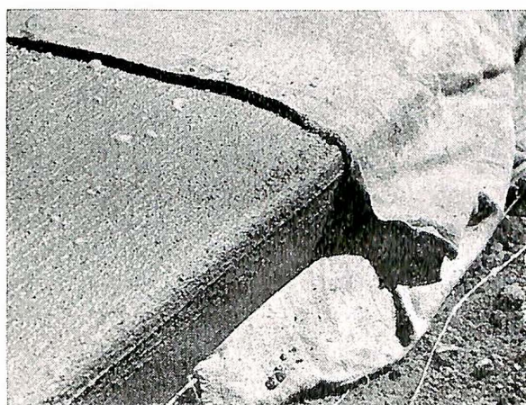
Fig. 9 b. Detalj av betongdekkets kant like etter at glideformen er passert.
