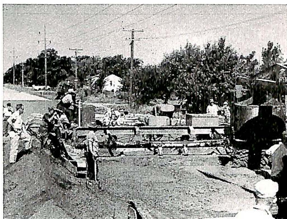
Fig. 9 a. Veimaskinen går på belter og er forsynt med lange glideformer.
