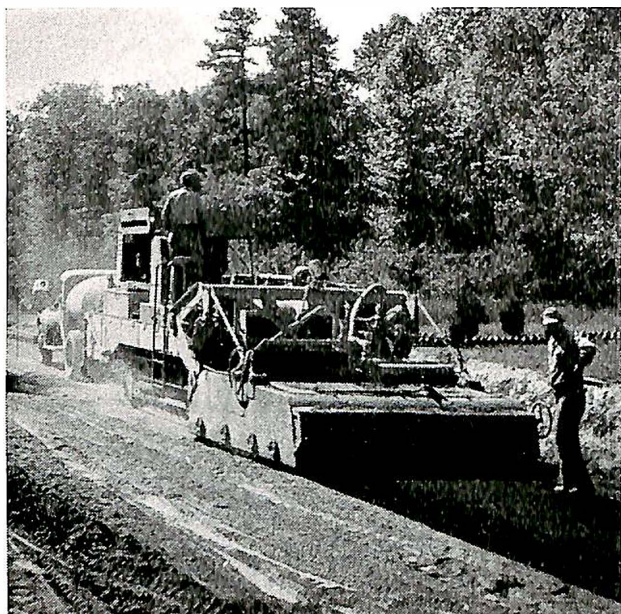
Fig. 17. Denne «single-pass»-maskin pulveriserer jorden, blander den med cement og tilsetter vann i en operasjon og etterlater seg dekket ferdig til komprimering.
