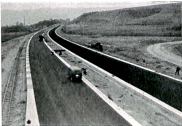
Fig. 12. Kanter av hvit betong på asfaltdekke i Tyskland.
