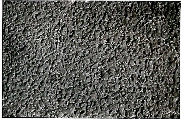
Fig. 9. Asfaltdekke på hovedvegen Malmö—Karlskrona. En slik vegoverflate ansees som gunstig.
