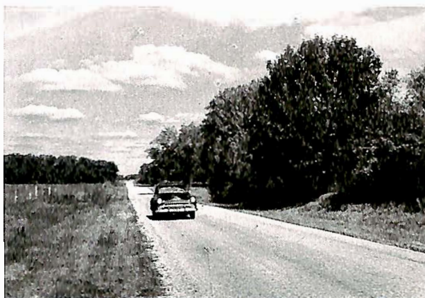
Fig. 13. Denne soilcementvegen på State Route 26 i Winnebago County nordvest for Chicago har gjort god tjeneste i over 20 år.
