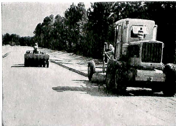
Fig. 11. Under den siste utforming av tverrsnitt og lengdeprofil blir alle småhaugene som er blitt igjen bak bladet og hjulspor etter motorskraperen fjernet ved en skrape av en eller annen type.
