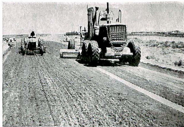
Fig. 12. Den endelige jevne overflate blir i alminnelighet oppnådd ved at et tynt lag av overflaten blir fjernet av en motorskraper. Overflaten blir derpå lett fuktet med vann og valset med gummihjulvalse (luftgummi). Den endelige behandling består i ytterligere en lett dusj av vann for å fylle porene. Derpå blir det påført en «grunning» av bitumen for å sikre at vannet ikke skal fordampe fra blandingen. Til slutt blir det så lagt ut et asfaltlag på 20 mm tykkelse.
