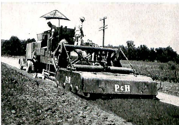
Fig. 9. Mobil blander som pulveriserer jorden og blander i cement og vann i en operasjon, og etterlater blandingen på vegen ferdig til komprimering. Når disse blandere brukes, blir cementen i alminnelighet tilsatt ved mekaniske spredere som vist på fig. 7.
