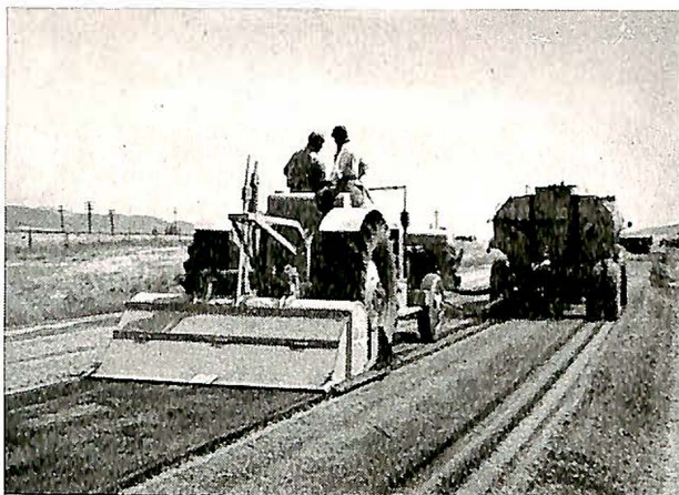
Fig. 8. Etter at vegbanen er planert, kan grunnen pulveriseres ved mange overkjøringer med roterende blandere med påsatte hakker. Cementen blir tilsatt som vist i fig. 5 og 6. Den etterfølgende blanding av cement og jord som vist på bildet foregår ved hjelp av den samme roterende blander, som kjører en rekke ganger over vegbanen.
