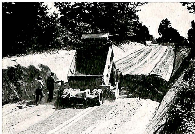
Fig. 7. Etter at vegbanen er ferdig planert, kan cementen også bli tilsatt ved hjelp av mekaniske cementspredere av forskjellige typer.
