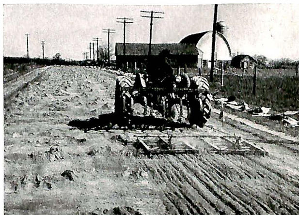
Fig. 6. Når den metode for cementspredning som er angitt på fig. 5 blir brukt, foregår spredningen i lengderetningen ved at en harv med tinner blir trukket 2—3 ganger langs vegbanen.
