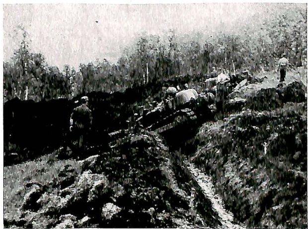
Fig. 4. Bulldozer i arbeid.
