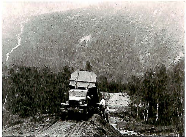
Fig. 3. Fyllmassekjøring.
