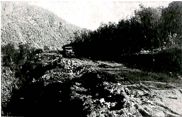
Fig. 2. Transport av bærelagsmasser.
