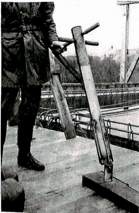
Fig. 7. Rør for tildanning av den spiralformede vifte i kabelforankringen.
