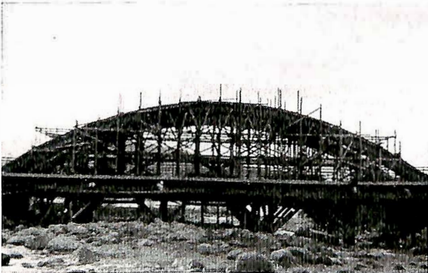
Fig. 6. Stillas for buen. Forspenning av kablene.
