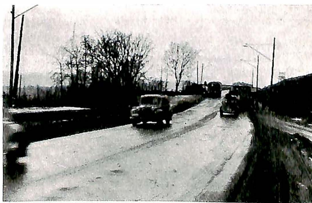
Fig. 2. Tosidig bussholdeplass på Trondheimsvegen i Oslo.
