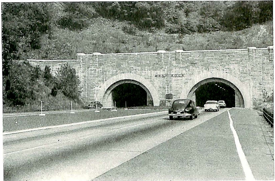
Fig. 2. Dei to tunnelane gjennom West Rock, ein for kvar køyrebane.
