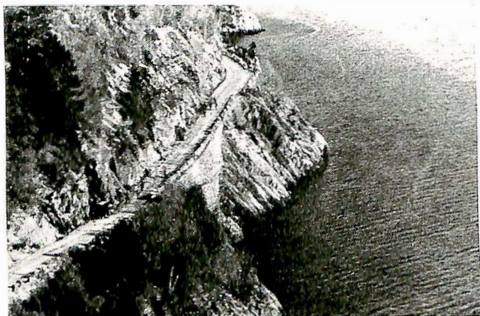
Fig. 1. Vegpartiet før sprengningen.
