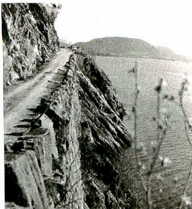
Fig. 2. Vegmuren før sprengningen.
