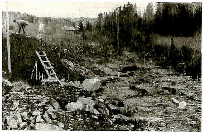
Fig. 13. Vakås 1954. Motfylling av stein utlegges. Poretrykksmåling i den underliggende leire.
