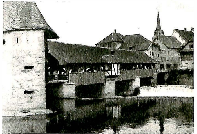
Fig. 4. Gammel, nylig reparert bru på hovedvegen Zürich—Bern.
