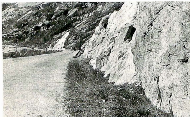
Fig. 13. Sustenpassvegen. Detalj uten grøft.
