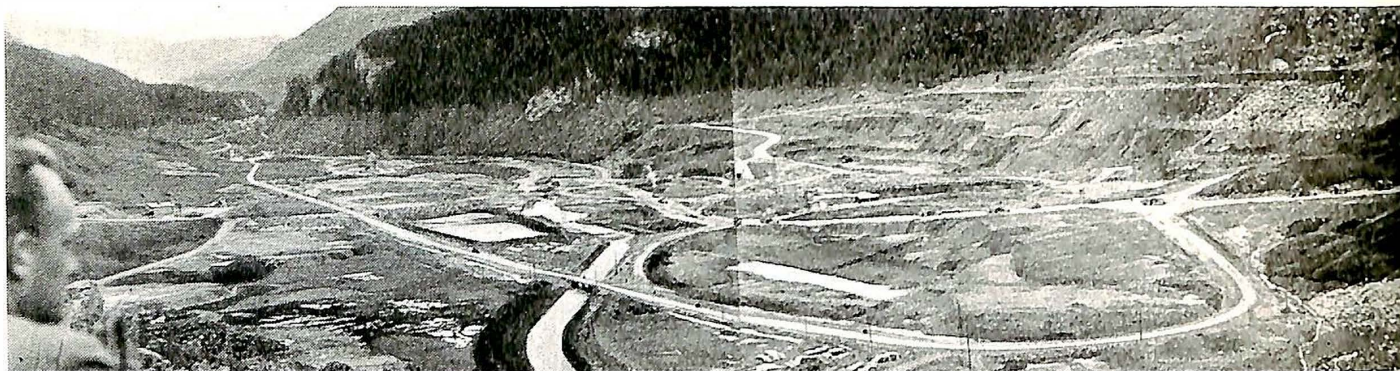
Fig. 9. Jorddammen ved Marmorera under utførelse. Den
