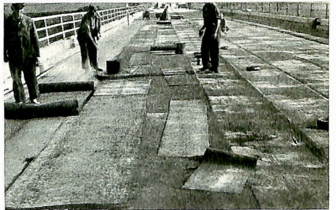
Fig. 7. Dei legg isolasjonslag på brudekket på Untermarchtalbrua.
