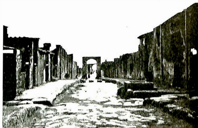
Fig. 2. Via di Mercurio, en av hovedgatene i det gamle Pompei. Steinene som ligger tvers over gaten er lagt der for at folk skal kunne gå tørrskodd over, og mellomrommene er tilpasset den vanlige avstand mellom hjulene på datidens vogner.
