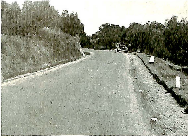
Fig. 3. Hovedvei i Italia, mellom Orvièto og Ficulde. Mellom asfaltdekket og den gjenfylte grøft er det støpt små betongklosser. Disse er dårlig likt av bilistene, som stadig kommer borti dem og får ødelagt bildekkene.
