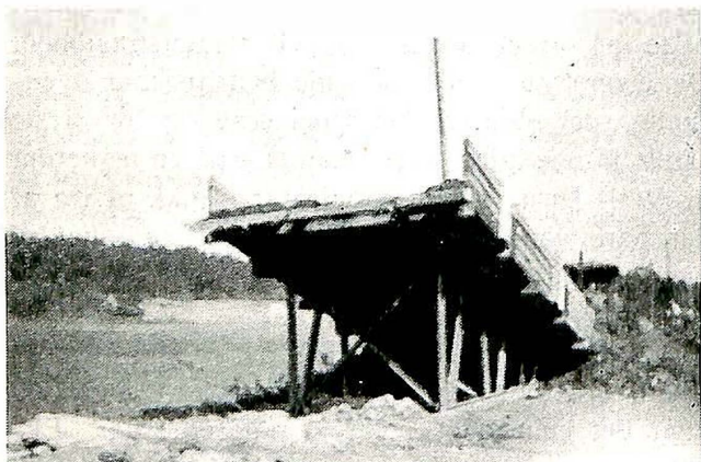
Fig. 1. Rampen ferdig montert.
