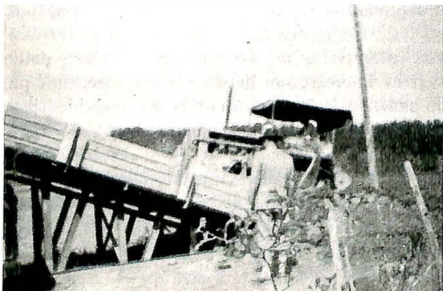
Fig. 2. Lasterampen med bulldozer.
