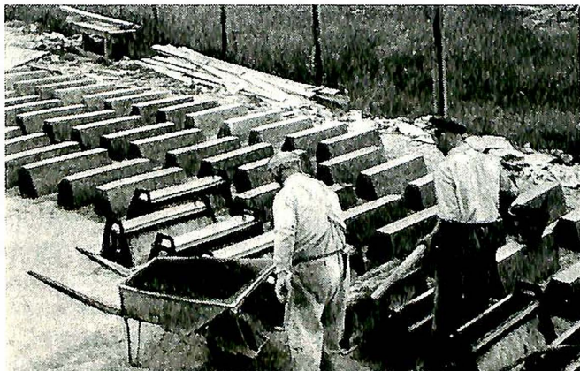
Fig. 1. Fremstilling av lameller.
