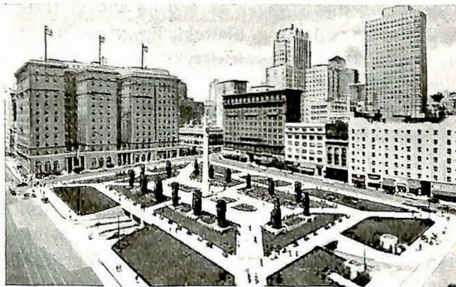
Fig. 49. Parkeringsplassen under Union Square i San Francisco. Det er 4 etasjer under jorden hvor det er plass for 1700 biler.
