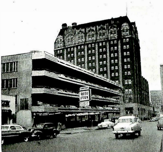
Fig. 48. Parkeringshus i Minneapolis sentrum. Ytre vegger brukes ikke så ventilasjonsproblemet er løst meget lett. To etasjer under jorden og fem over. Plass for 535 vogner.
