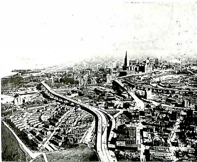
Fig. 44. Slike tiltak må til hvis de regulerende myndigheter ikke i tide er klar over hvordan trafikken vil vokse. Cleveland i Ohio (900 000 innb.) har måttet bygge — med uhyre kostnader — høybaner for biltrafikkens gjennomføring. Gjennomgangs- trafikken tar vegen til venstre og kommer frem til bredden av Eriesjøen. Vegen til høyre fører inn til sentrum.
