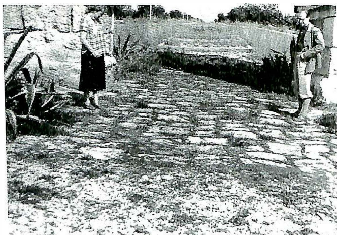
Fig. 8. Her ser vi den gamle steinsatte romarvegen gjennom (under) den romerske triumfbogen nord for Tarragonia i Spania. Den nye vege er no bygd med ei køyrebane på kvar sida av Triumfbogen.
