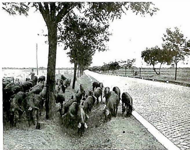
Fig. 4. Ein breid og bein veg i Gamal-Kastilia. Ein flokk brune, blanke griser beiter langs vegen.
