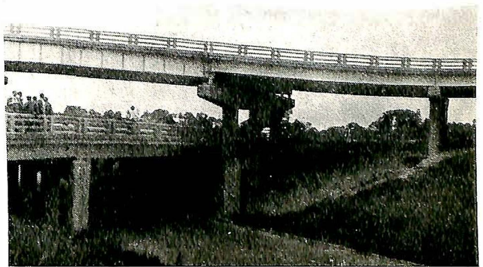
Fig. 4. Planfri kryssing av 3 hovedveger ved Willow Run, Michigan. (Flomvannet i Javestliggende plan ved slike «grade-separations» måtte mange steder pumpes opp i kloakk.)
